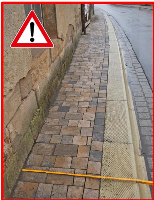
Abb. 29: Trotz 18 cm-Hochbord mit Spurführung ist an dieser Haltestelle bei nur 1 m Gehwegbreite keine Barrierefreiheit gegeben: keine ausreichende Rangierfläche für Rollstuhlfahrer und sehr schmale Zuwegung.
