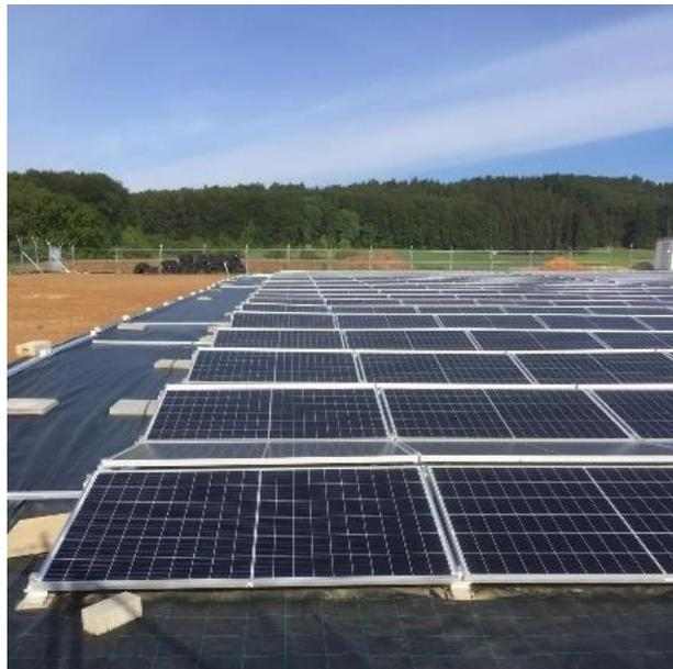
**Abbildung 32: Beispiel einer bodennah angebrachten PV-Anlage in Ost-West-Ausrichtung**
