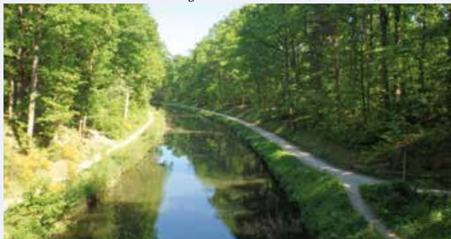
Ludwig-Donau-Main-Kanal (Alter Kanal), Wendelstein
