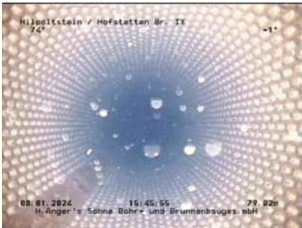
Distanz: 79.82m Foto Nr.: 25 Blick in den Filterrohrbereich
