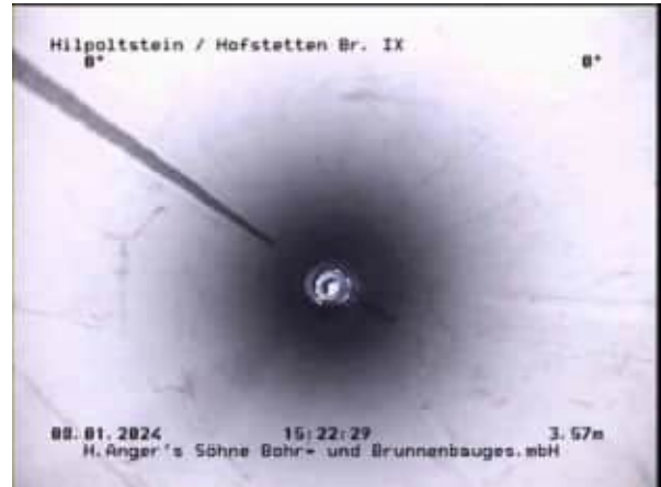
Distanz: 3.57m Foto Nr.: 6 Blick in den Vollrohrbereich
