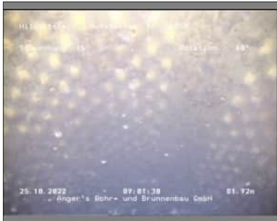
Foto: 1_1_35_A.JPG 81,92m, Filterschlitz geschlossen
