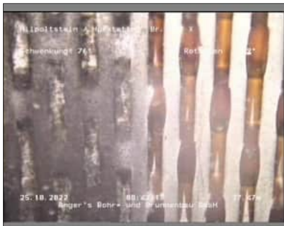
Foto: 1_1_17_A.JPG 37,47m, Filterschlitzte geschlossen
