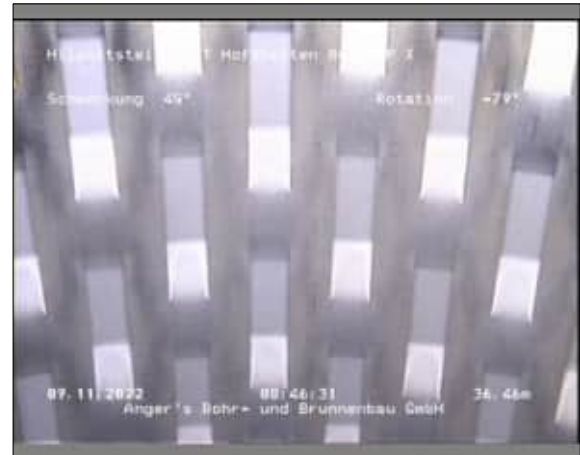
Foto: 1_1_9_A.JPG 36,46m, Filterschlitz offen
