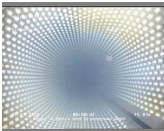
Foto: 1_1_17_A.JPG 75,83m, Blick in den Filterrohrbereich
