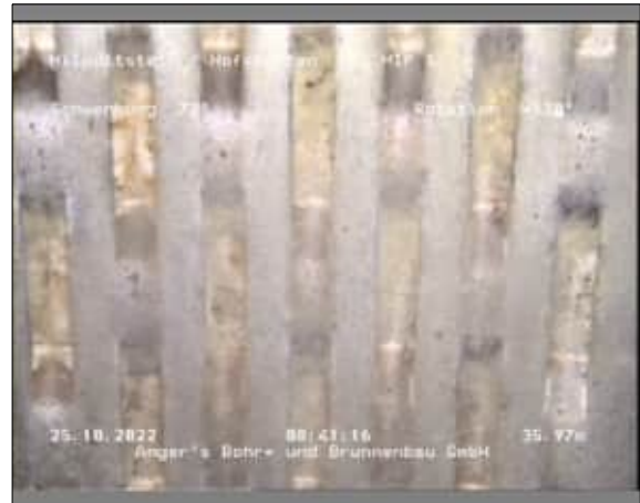
Foto: 1_1_16_A.JPG 35,97m, Filterschlitzte geschlossen
