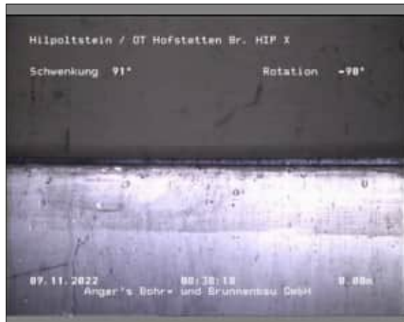
Foto: 1_1_1_A.JPG 0,00m, OK Brunnenkopf
