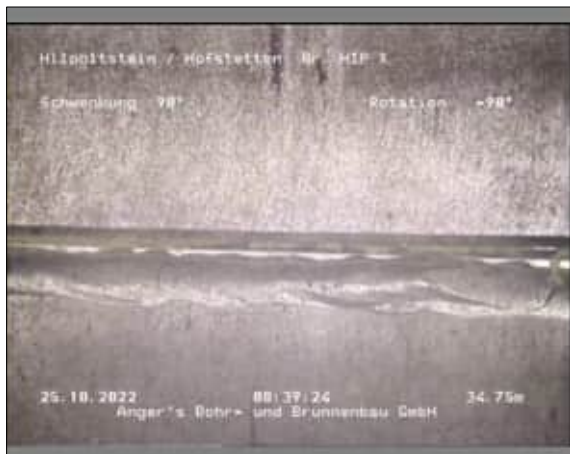
Foto: 1_1_14_A.JPG 34,75m, OK Filterrohr
