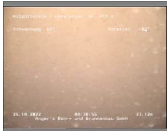
Foto: 1_1_10_A.JPG 23,12m, Ablagerungen eisenhaltig
