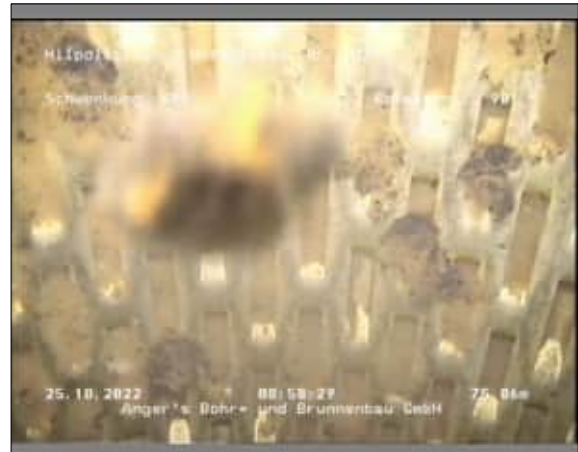
Foto: 1_1_32_A.JPG 75,06m, Filterschlitz teilweise geschlossen
