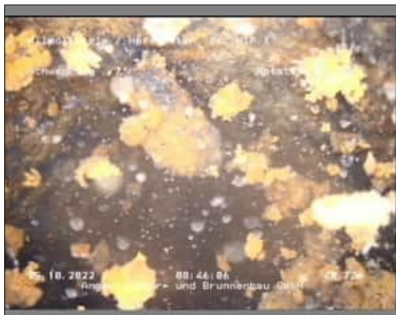
Foto: 1_1_21_A.JPG 40,73m, Blick in den Filterrohrbereich
