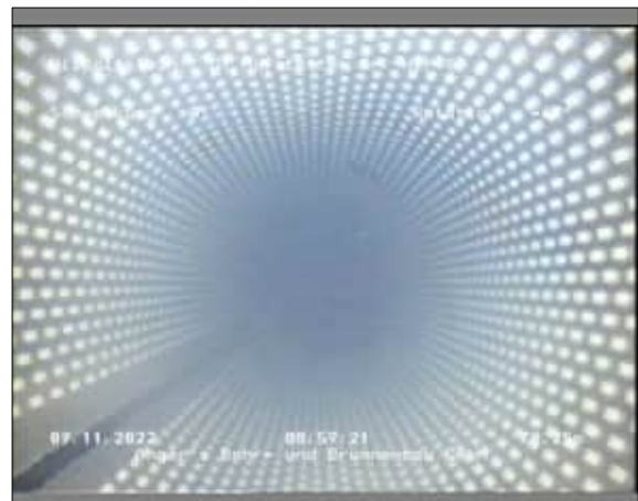
Foto: 1_1_18_A.JPG 79,25m, Blick in den Filterrohrbereich
