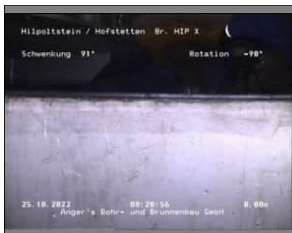
Foto: 1_1_1_A.JPG 0,00m, OK Brunnenkopf
