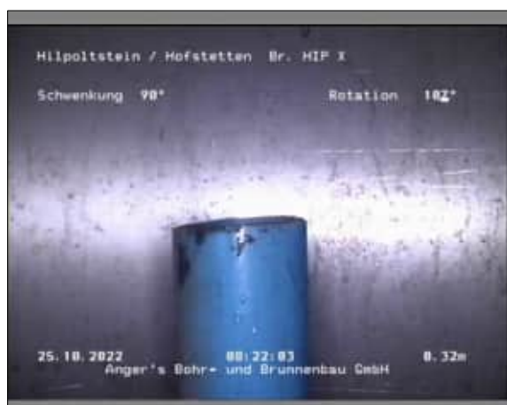
Foto: 1_1_3_A.JPG 0,32m, OK Peilrohr 2
