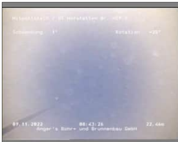
Foto: 1_1_7_A.JPG 22,46m, Blick in den Vollrohrbereich
