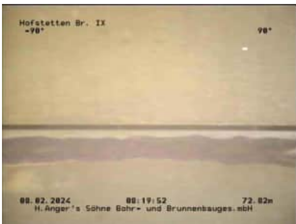
Distanz: 72.82m Foto Nr.: 15 OK Vollrohr
