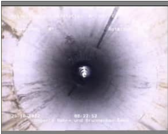
Foto: 1_1_5_A.JPG 1,31m, Blick in den Vollrohrbereich
