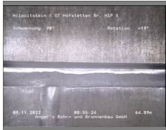
Foto: 1_1_13_A.JPG 64,89m, OK Vollrohr
