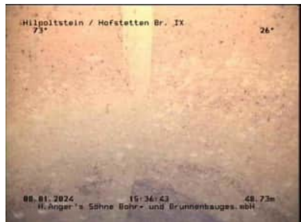
Distanz: 48.73m Foto Nr.: 16 Ablagerungen eisenhaltig
