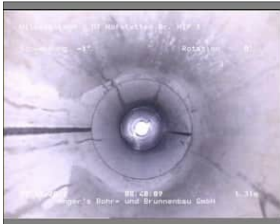
Foto: 1_1_5_A.JPG 1,31m, Blick in den Vollrohrbereich
