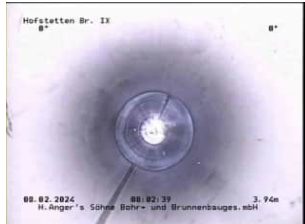
Distanz: 3.94m Foto Nr.: 6 Blick in den Vollrohrbereich
