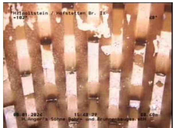
Distanz: 88.40m Foto Nr.: 28 Ablagerungen kalkhaltig
