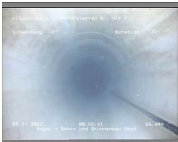
Foto: 1_1_14_A.JPG 65,49m, Blick in den Vollrohrbereich
