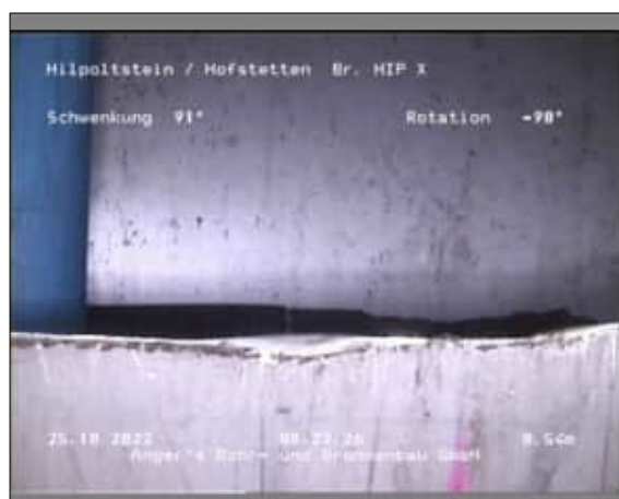
Foto: 1_1_4_A.JPG 0,54m, OK Vollrohr
