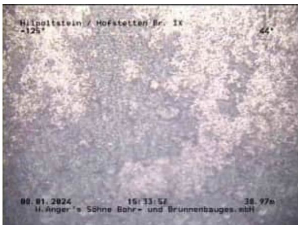
Distanz: 38.97m Foto Nr.: 15 Ablagerungen feinsandig
