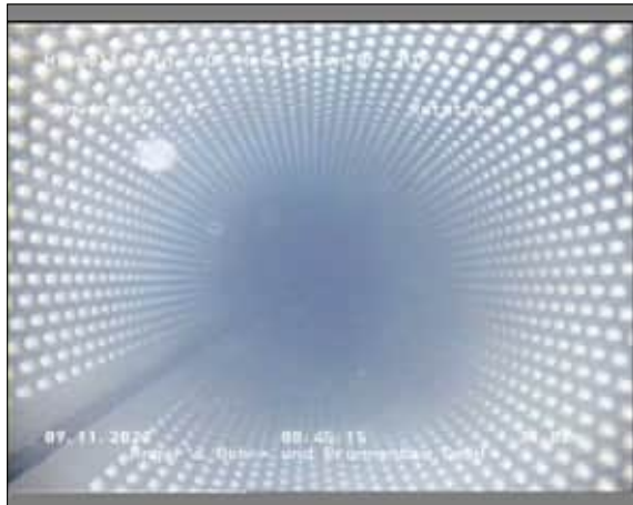
Foto: 1_1_8_B.JPG 34,82m, OK Filterrohr
