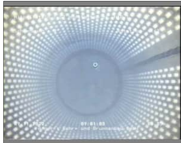
Foto: 1_1_20_A.JPG 85,83m, Blick auf Auflandung
