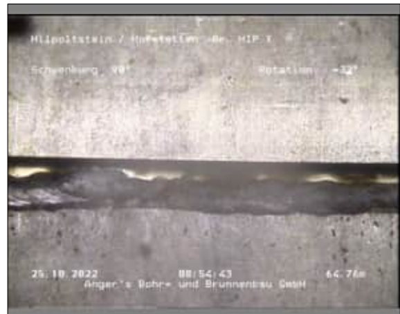
Foto: 1_1_28_A.JPG 64,76m, OK Vollrohr
