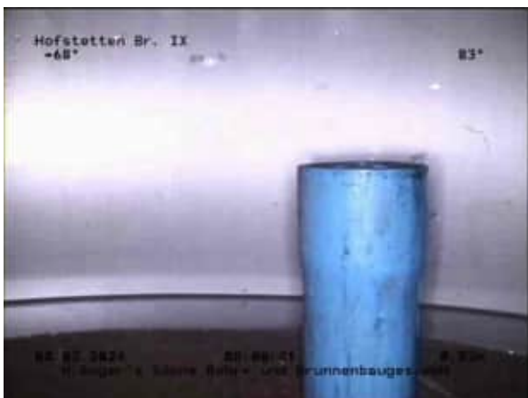
Distanz: 0.82m Foto Nr.: 3 OK Peilrohr 2
