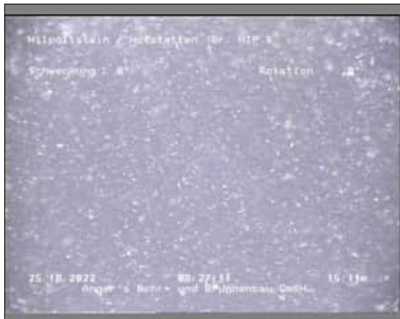
Foto: 1_1_9_A.JPG 15,11m, hoher Schwebstoffanteil
