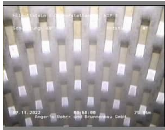
Foto: 1_1_16_A.JPG 75,06m, Filterschlitz offen
