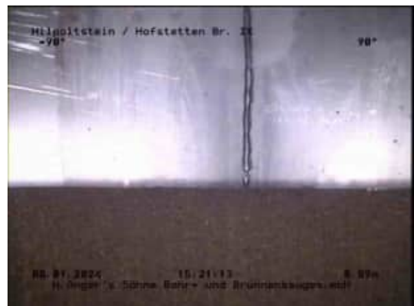
Distanz: 0.89m Foto Nr.: 4 OK Sperrohr / DN 700
