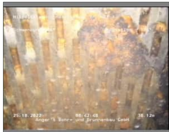
Foto: 1_1_18_A.JPG 38,12m, Filterschlitzte geschlossen
