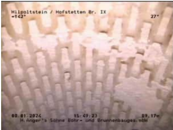
Distanz: 89.17m Foto Nr.: 29 Filterschlitz geschlossen
