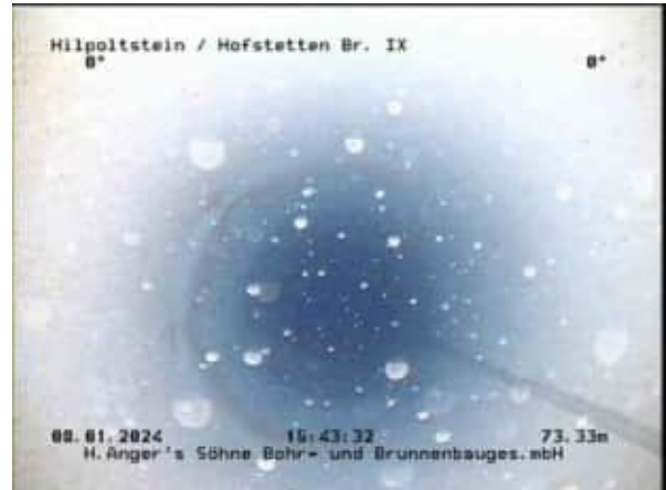
Distanz: 73.33m Foto Nr.: 22 Blick in den Vollrohrbereich
