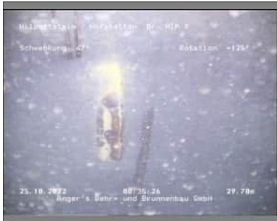
Foto: 1_1_12_B.JPG 29,70m, Scheuerstelle
