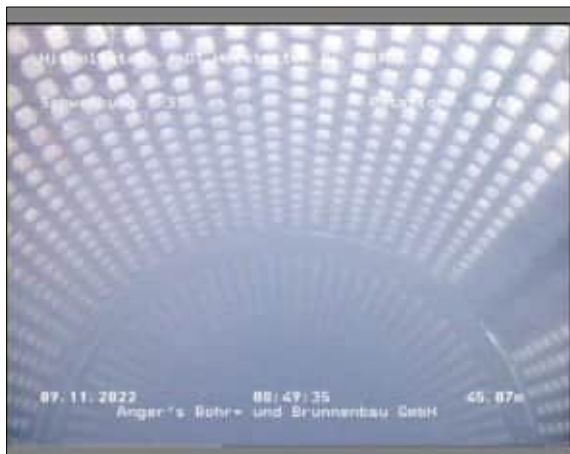
Foto: 1_1_10_A.JPG 45,07m, Blick in den Filterrohrbereich
