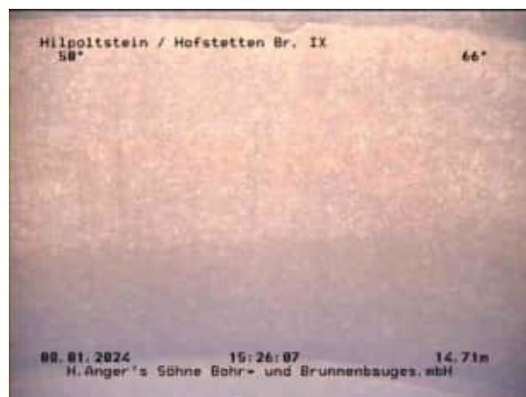
Distanz: 14.71m Foto Nr.: 10 Ablagerungen eisenhaltig
