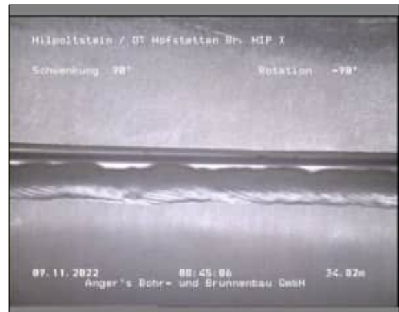
Foto: 1_1_8_A.JPG 34,82m, OK Filterrohr
