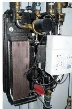
Abbildung 6 Frischwasserstation
