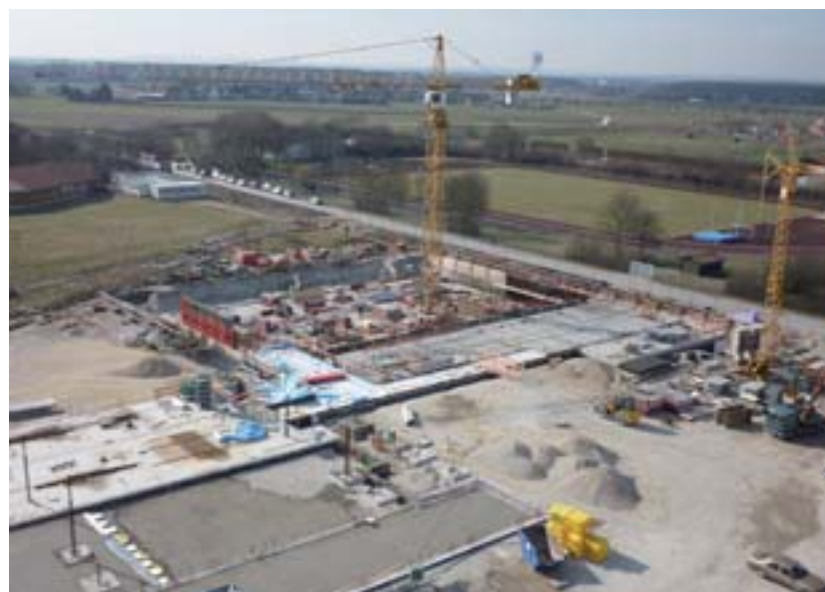
Die Arbeiten am Rohbau des Gymnasiums sind in vollem Gang.
