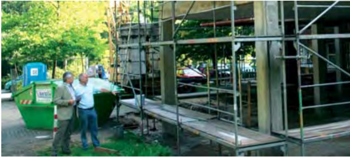
Klinikvorstand Werner Rupp informiert Landrat Eckstein über den Stand der Baumaßnahme
